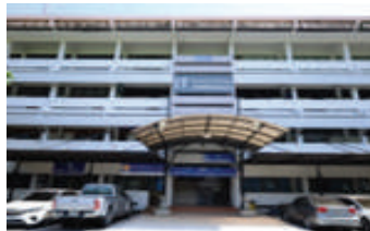
อาคาร ๑ อาคารเรียน ลักษณะจำนวน ๔ ชั้น
