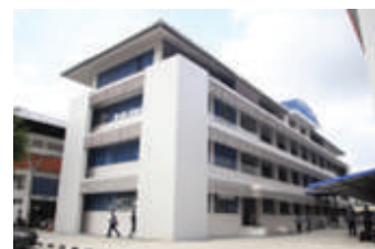
อาคาร ๑๘ ลักษณะจำนวน ๔ ชั้น
