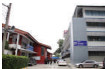
อาคาร ๑๕ อาคารเรียน ลักษณะจำนวน ๔ ชั้น
